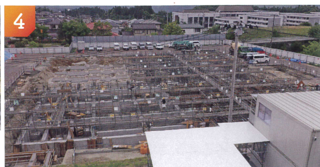
■令和5年5月 基礎工事
