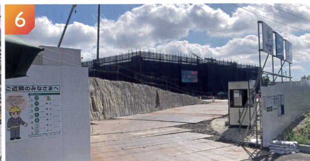
■令和5年8月 入口の完成
