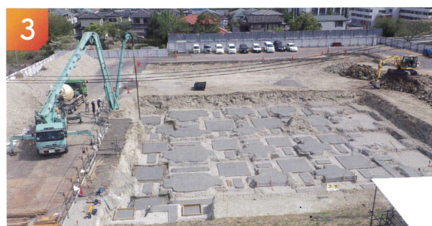
■令和5年4月 いよいよ工事が始まりました。
